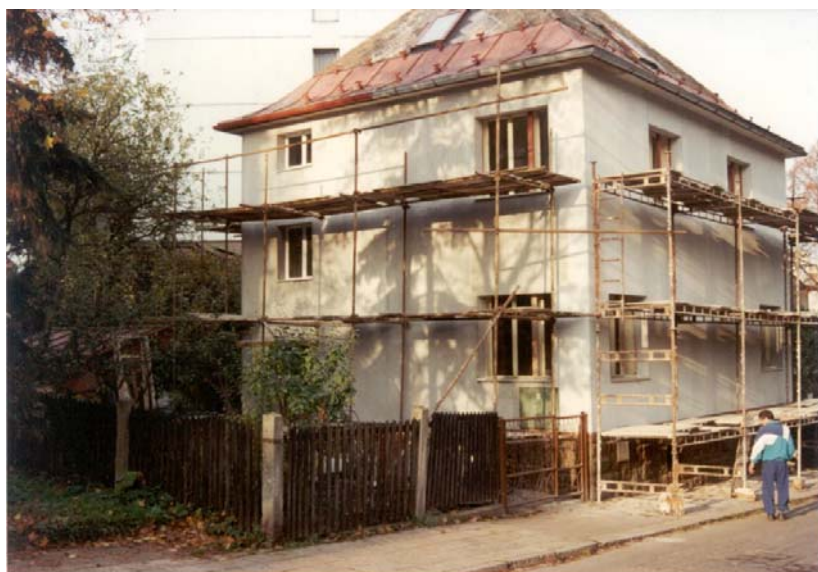
Obr. 5: Pravá část lešení „Haki“, levá část trubkové lešení; lešení vykazuje hrubé závady, které ohrožují život a zdraví pracovníků
