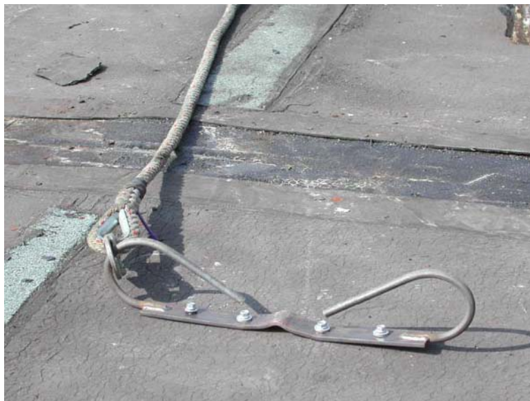
Obr. 6: Příklad kotvení OOPP proti pádu, u kterého není prokázána únosnost
